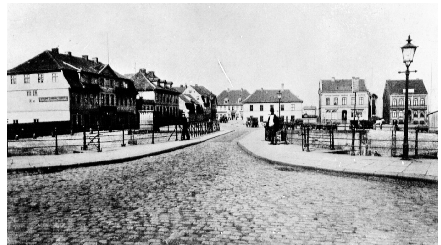
Abb. 27 ↓ | Der Canalplatz aus östlicher Richtung: Links der König von Schweden, das Postgebäude und der weisse Schwan, im Hintergrund das Hotel Stadt Lüneburg, rechts neben dem Zollamt die beiden Wohnhäuser Kanalplatz 5 und 6 (heute Kanalplatz 6 und 8) in einer Aufnahme von 1895 197
