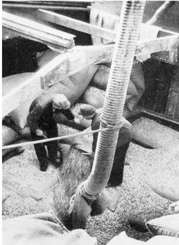
**Abb. IV 36 Säcke mit Erdnusskernen wurden vor dem Löschen fachgerecht aufgeschnitten, damit sie bei der Schrotverladung wieder verwendet werden konnten. Aufnahme von 1956<sup>137</sup>**
