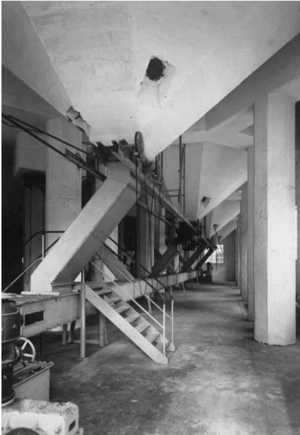
Abb. IV 35 Förderanlage im Saatsilo Westlicher Bahnhofskanal, Aufnahme von 1937<sup>134</sup>
